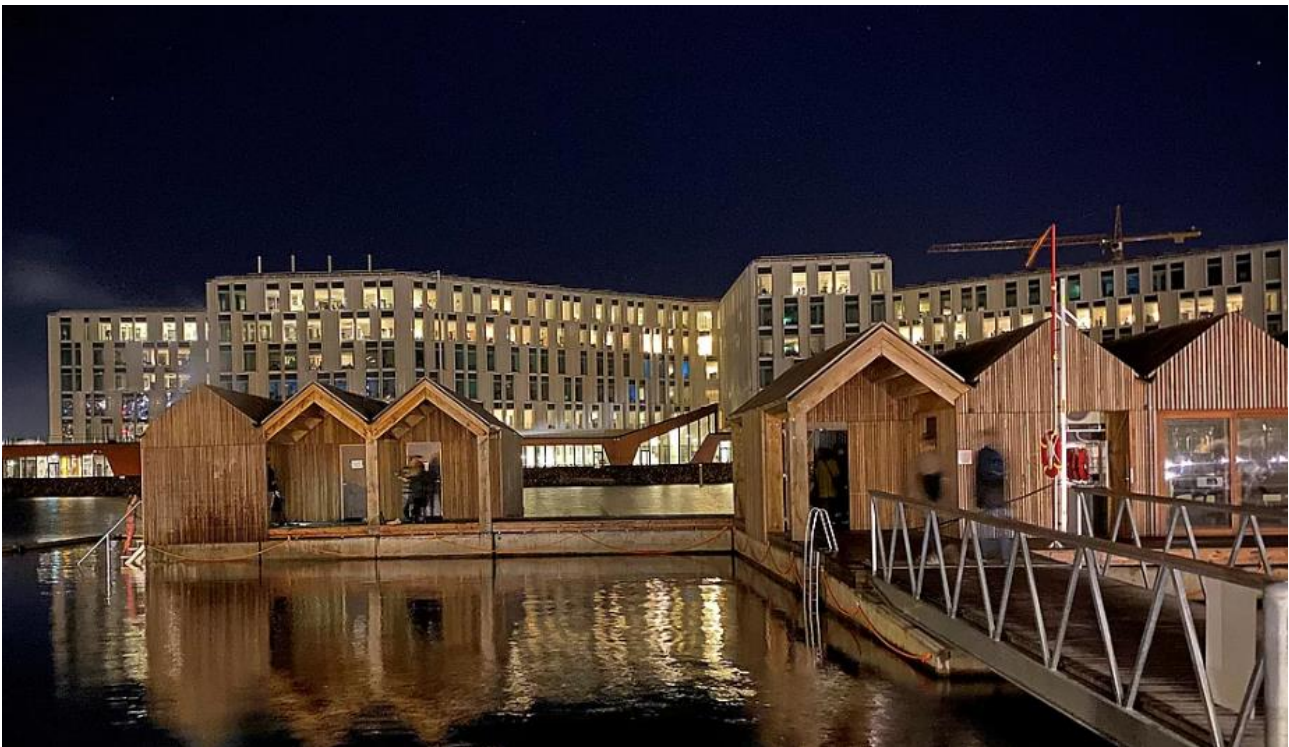
Billedtekst: Branden opstod i elinstallationen til saunaen yderst til venstre og røgen kan lige anes på dette pressefoto (Foto: TV2 Lorry).
